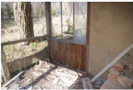
VZD Kadastrā reģistrā fiksēta, bet Kalētu pagasta zemesgrāmata nodalījumā Nr.100000504445 neregistrēta pirts ēka ar kadastra apzīmējumu 6464 002 0037 002
